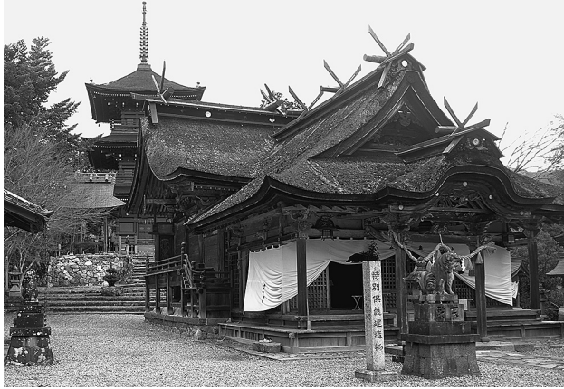
改修工事が行われる柏原八幡宮本殿
